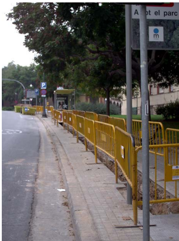
Foto 1: Vista general de la rasa 1 al Passatge de la Exposició.
